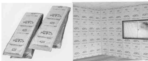
写真1 長尺マットの室内壁への施工状況
