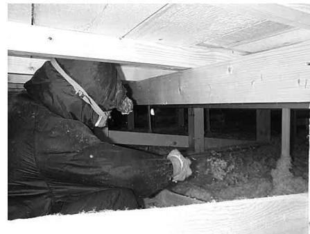
写真2 ロックウール吹込み用断熱材の施工状況
